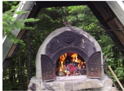
base sur laquelle sera versé l'argile tout en prenant soin de laisser une ouverture sur le côté et une autre sur le haut du four, puis nous le laissons sécher un peu et nous mettons le feu dans la paille, ce qui permet de faire sécher et durcir l'argile, explique Ammi Benaïssa.
