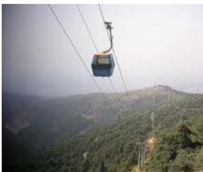
Les essais techniques ont été lancés dernièrement sans charges et devront durer un mois avant d'être suivis par d'autres avec des sacs de sable représentant une charge de 600 kg par cabine, a indiqué Attar Nouredine, ajoutant que l'opération d'aménagement des structures du téléphérique, lancée en novembre 2016, est totalement achevée.
