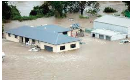
services du gouverneur dans un communiqué. Ces dégâts, selon eux, résultent "des constructions anarchiques que connaît la ville de Kananga".
