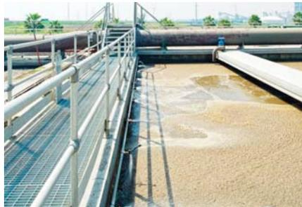
duction d'ozone dans l'eau afin d'en assurer sa désinfection. Grâce à ce traitement chimique, qui utilise les propriétés désinfectantes de l'ozone, les particules organiques, ou COV (composés organiques volatiles), sont systématiquement détruits, permettant ainsi la réutilisation des eaux usées.
