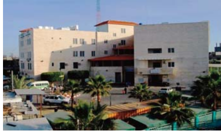
centre de santé Sheikh-Radwan avant et après sa
